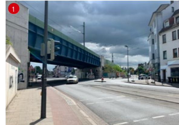
Hastedter Heerstraße, Blick nach Osten
