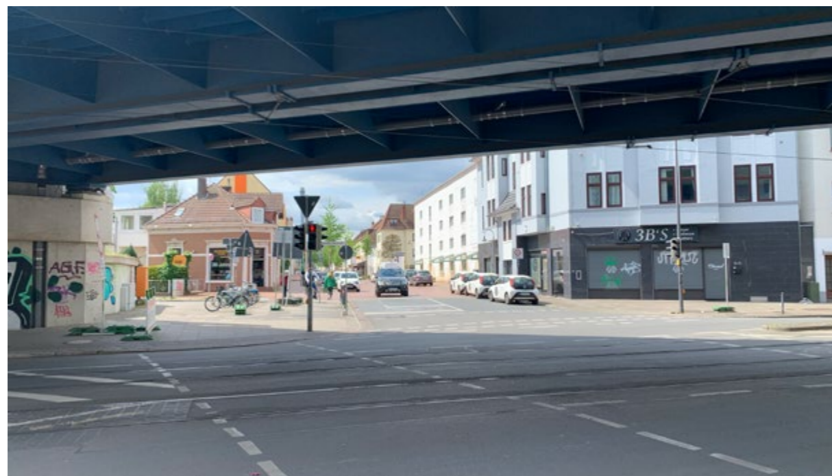
Kreuzung Hastedter Heerrstraße/Hohensteiner Straße mit Eisenbahnbrücke
