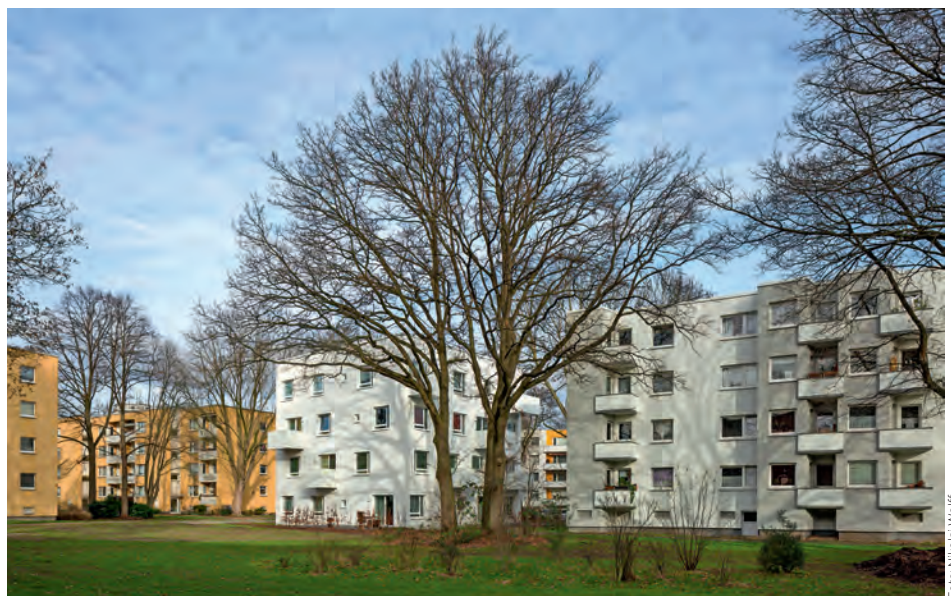
Bremer Punkt 10, Bispinger Straße 1A, 2022 fertiggestellt
