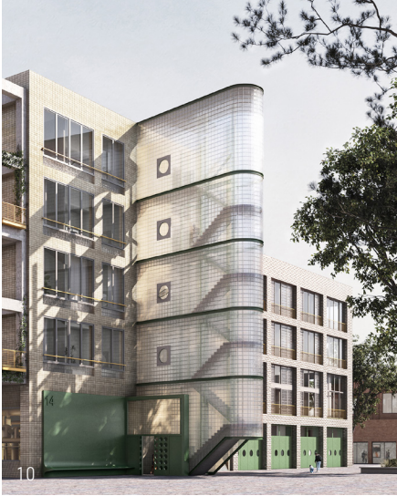
10 / Nordfassade Gebäude 14 nach der Sanierung Quelle: S.M.A.Q.
