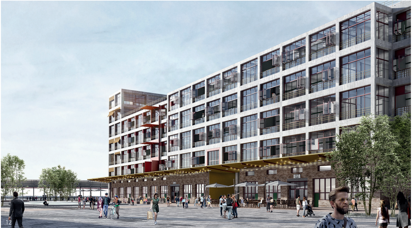
12 / Ostfassade Gebäude 25 nach Sanierung Quelle: SMAQ
