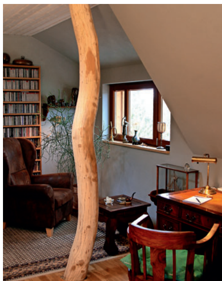
Naturbelassene Robinienstütze mit statischer Relevanz im Wohnbereich
