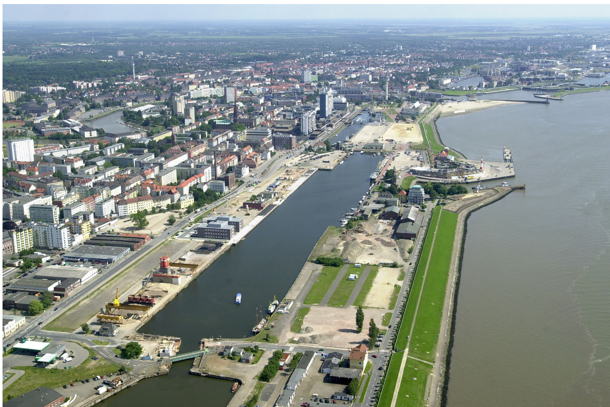
Abb. 39 Neuer Hafen während der Altlastensanierung 2002
