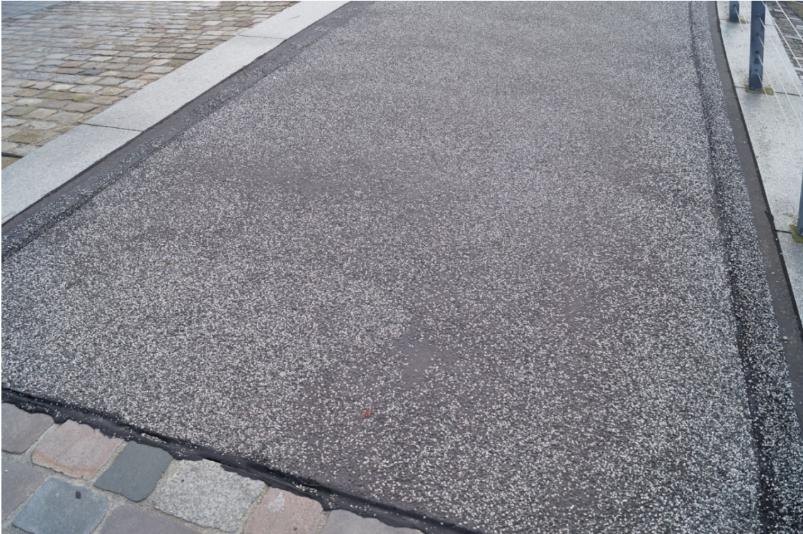
Abb. 25: Gußasphalt (Lloydockbrücke)
