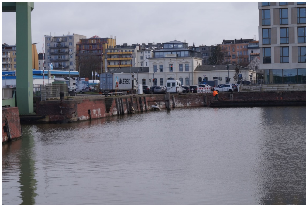
Abb. 7 Nordkaje östlich der Klappbrücke
