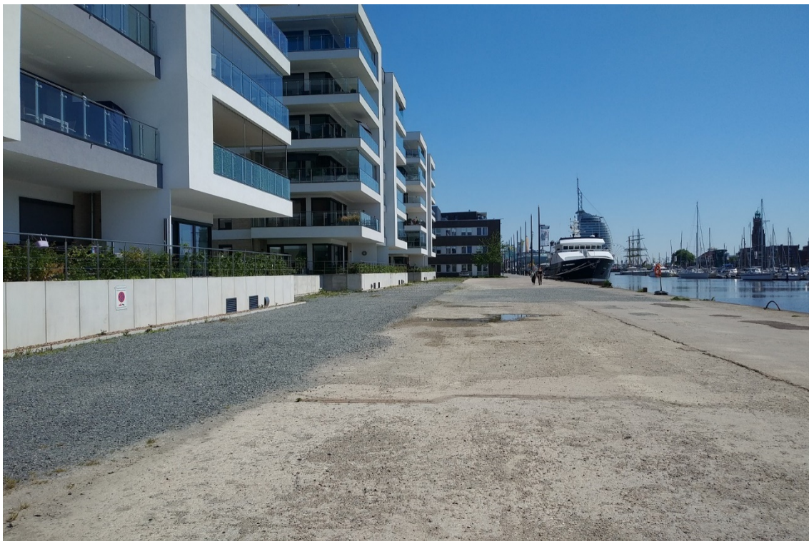
Abb. 8: aktueller Zustand der Flächen zwischen Hafenbecken und neuen Wohngebäuden
