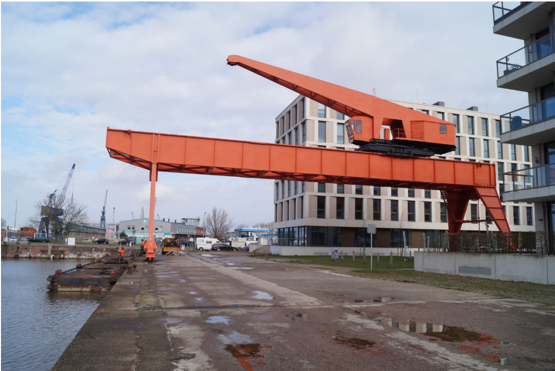
Abb. 20 Portalkran der Kiesumschlagsanlage
