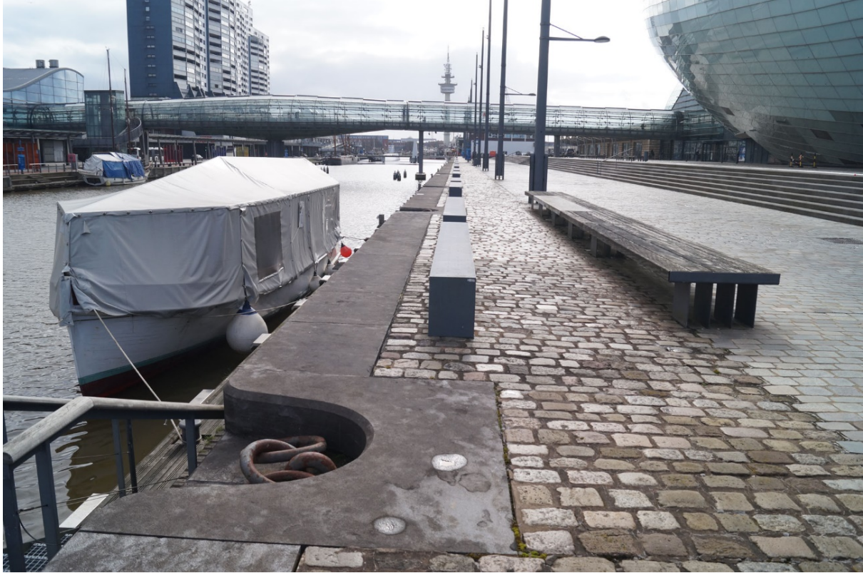
Abb. 34 subtile Absturzsicherung am Alten Hafen durch Bänke
