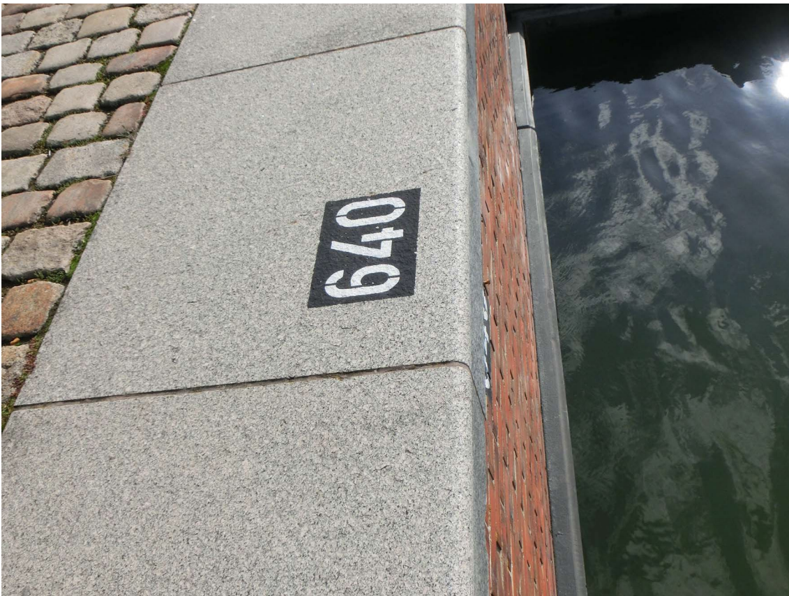
Abb. 18 Markierung „Kajenmeter“ (Südwestkaje)
