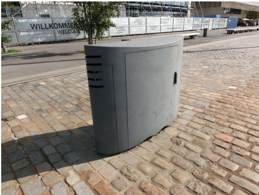
Abb. 32 Schiffsanschlüsse/ Festplatzverteiler (Südostkaje)
