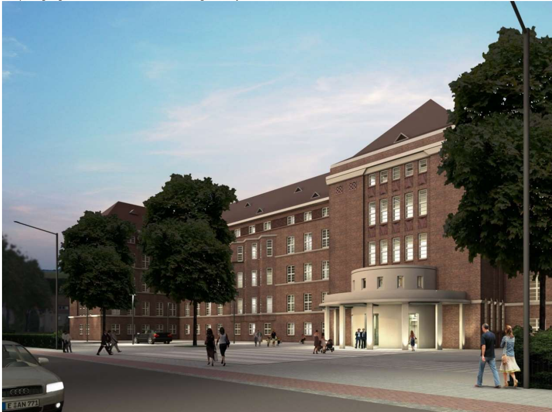
Haupteingang Teilersatzneubau an der St.-Jürgen-Straße
