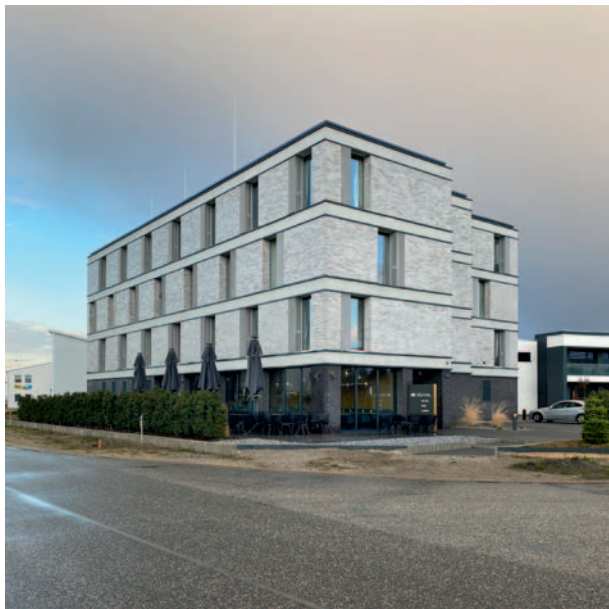
Foto: KONTEXT ARCHITEKTEN
