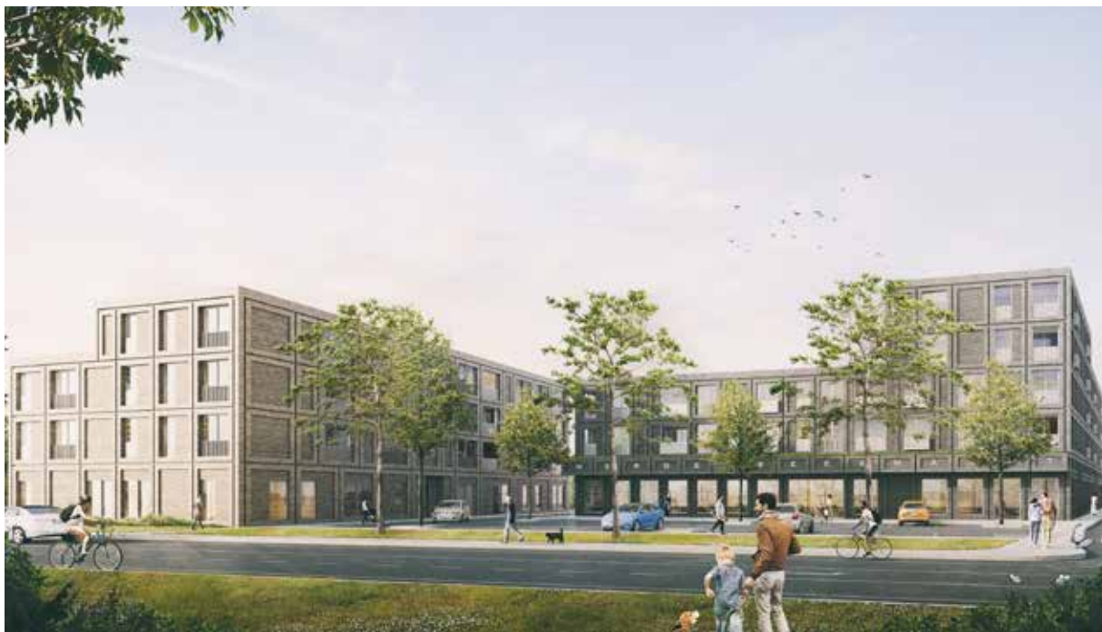
Abb. 12 links unten: Geschosswohnungsbau L1 mit 31 Wohnungen und gewerblicher Nutzung im Erdgeschoss Quelle: GEWOBA
