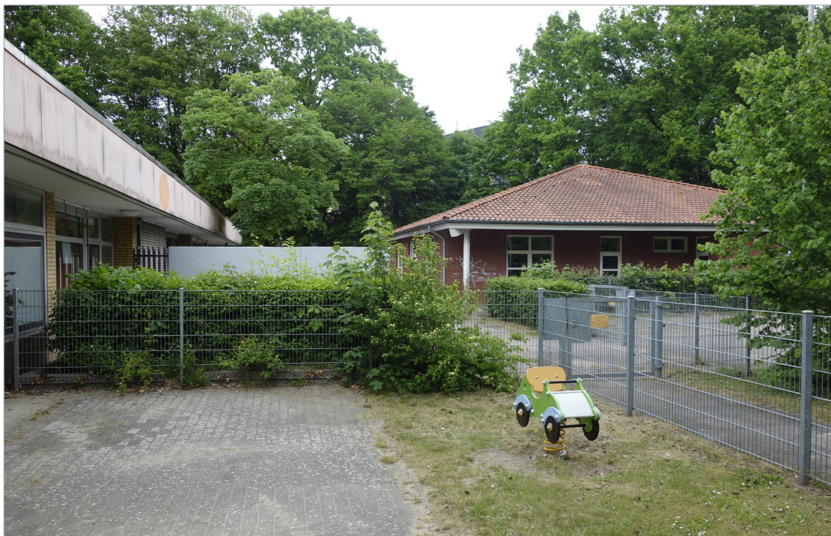
Abb. 16 | Blick auf das Bestandsgebäude der KiTa (links) und das Bestandsgebäude der U3-Kindergruppe (rechts)
