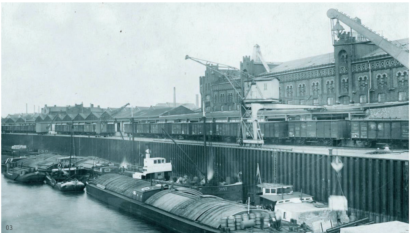
03 / „Alter“ Weserbahnhof, 1. Hälfte des 20. Jhds.; BREMENPORTS
