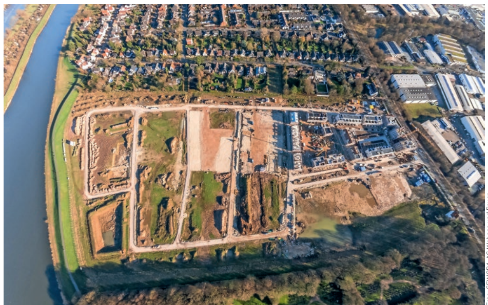
Baufeld G1 + G2, Gartenstadt Werdersee, Bremen-Huckelriede.
