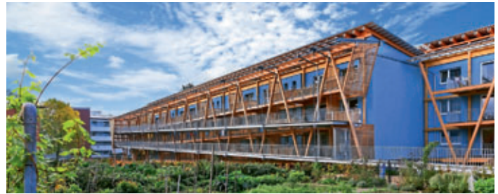
...und nach (2018) der Sanierungsmaßnahme.
